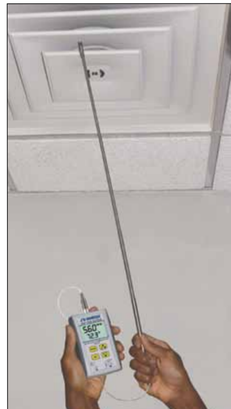
Medición del flujo de aire de un conducto de aire acondicionado.
