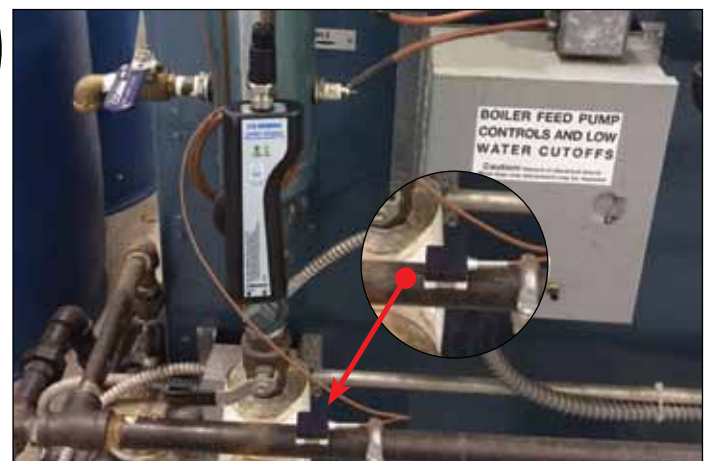
Figura 8: sonda 88401K midiendo la temperatura de la tubería
