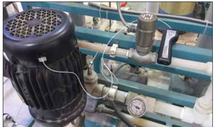
Figura 7: sensor SA1-RTD montado en el motor de la bomba
